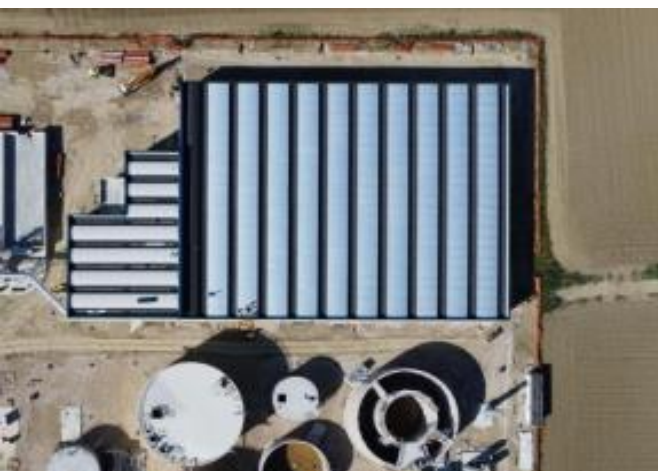
IMPIANTO BIOMETANO – Centro Italia (Teramo)
