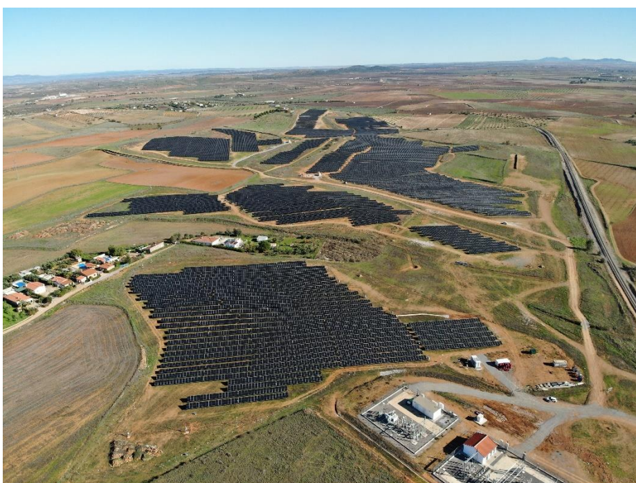
Impianto fotovoltaico a Zafra (Badajoz) costruito da Solarig
