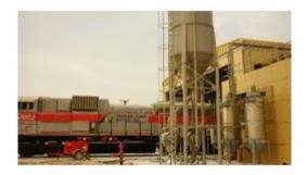
Gli impianti di rifornimento sabbia sono sistemi concepiti per l'approvvigionamento di sabbia nei serbatoi dei rotabili, utilizzati in vari sistemi di trasporto. Questi impianti offrono flessibilità in termini di configurazione, poiché possono essere forniti sia come installazioni fisse, che comprendono un silo di stoccaggio, un propulsore e serbatoi locali, sia come unità mobili.
